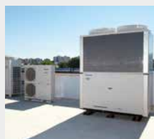
2012 Nouvelles unités de pompe à chaleur à gaz. Les systèmes DRV à gaz de Panasonic sont idéaux pour les projets avec des restrictions d'alimentation électrique.
